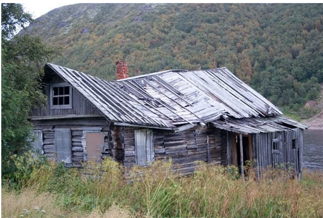
В дальней части поселка стоит несколько неотремонированных полуразвалившихся домов
