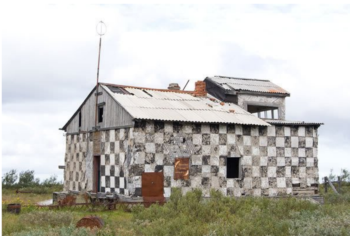
Аэродромное здание. На второй этаж уже не подняться – осыпалась лестница
