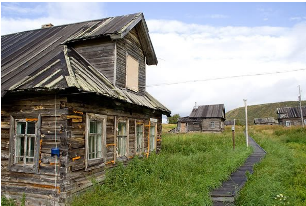
Вдоль центральной улицы села ведет довольно высокий настил из досок
