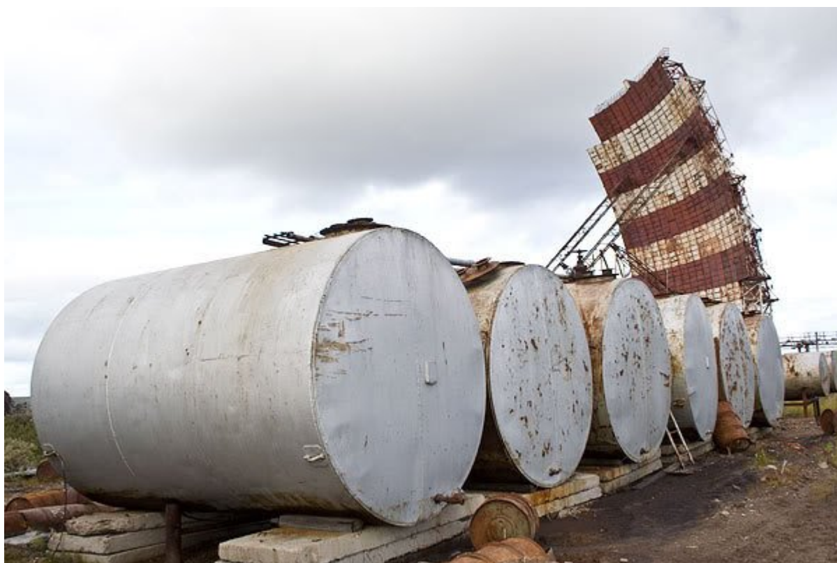
Два ряда цистерн – хранилище топлива, обеспечивавшее радиорелейной станции большой запас автономной работы
